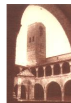
S.M. PROPEZZANO "Chiostro"
